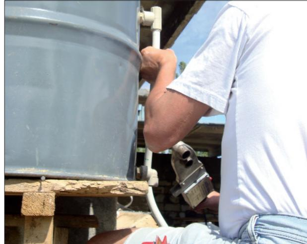
**Крок 6.** Під'єднайте теплообмінник до колектора (вище: вхід рідини, нижче: вихід рідини) та бак до системи водопостачання. Вхід холодної воді з системи водопостачання (або з додаткового резервуару) має бути розташований у нижній частині баку, а вихід нагрітої води до споживача - у верхній частині баку. Розташуйте кран в найнижчій точці, щоб мати можливість злити рідину (антифриз або воду) з системи (див. схему).
