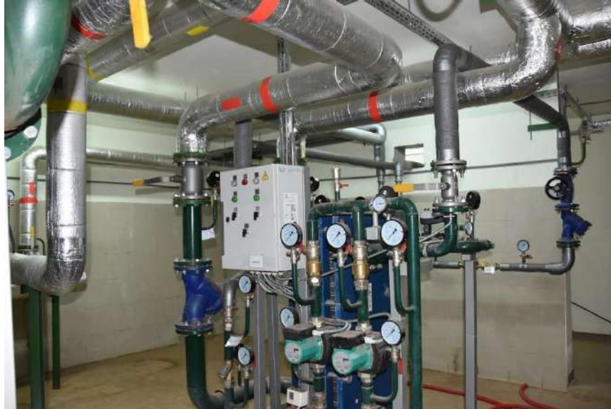
Рисунок 1 . Зовнішній вигляд встановленого ІТП та заміненних трубопроводів
