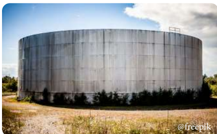
Резервуар зі сталі
