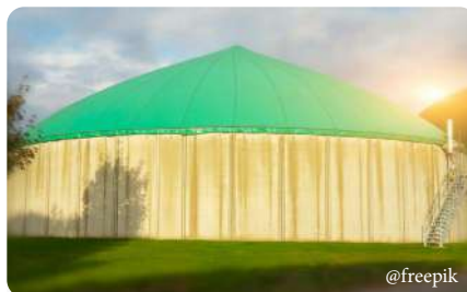
Залізобетонний резервуар з навісом
